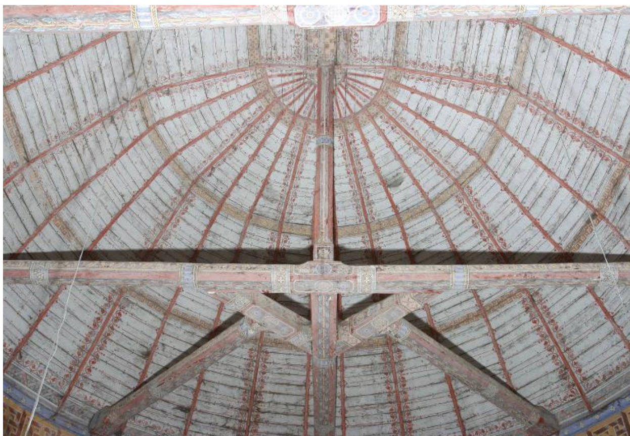
Le lambris de couverture au-dessus du chœur.
