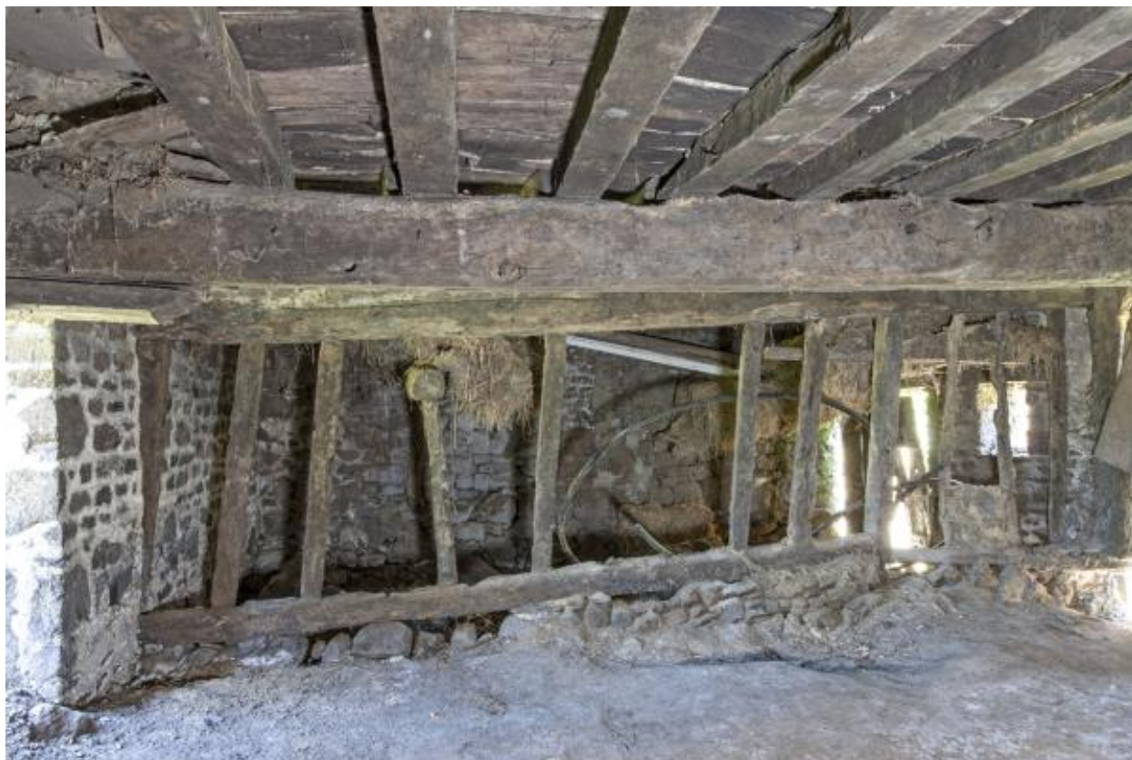
Cloison séparant l'étable du logis sud.
