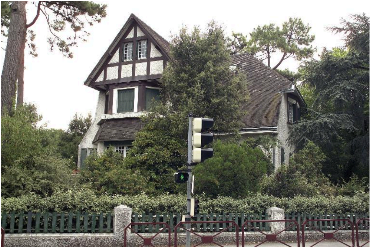
Façade avenue du Bois-d'Amour.
