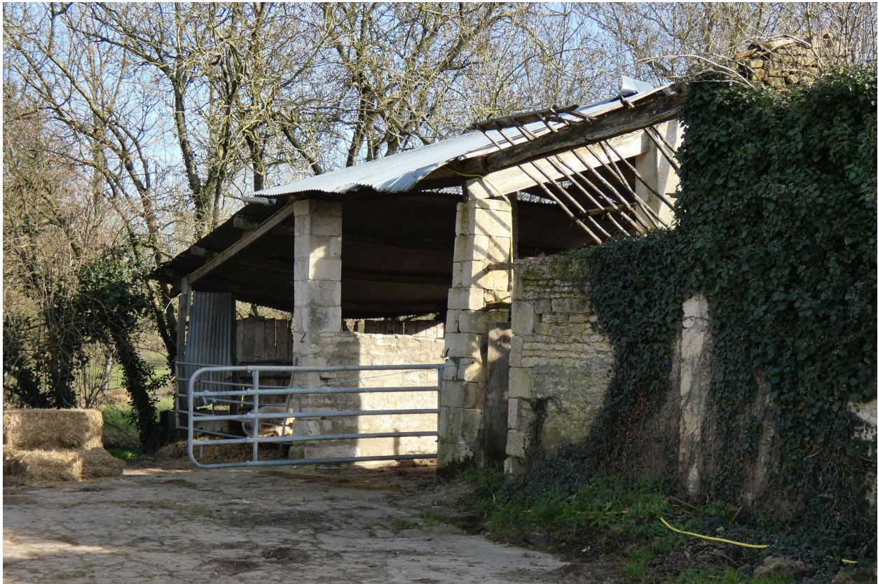
Le hangar à piliers en pierre vu depuis le nord-ouest.
