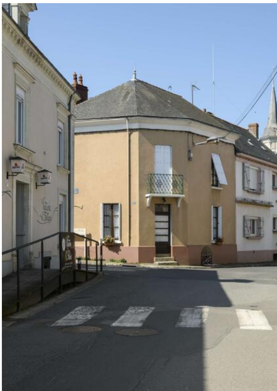
Beausse, 2 rue des Mauges. Ancien hôtel de voyageurs, actuellement maison, 4e quart 19e siècle, 2e moitié 20e siècle.
