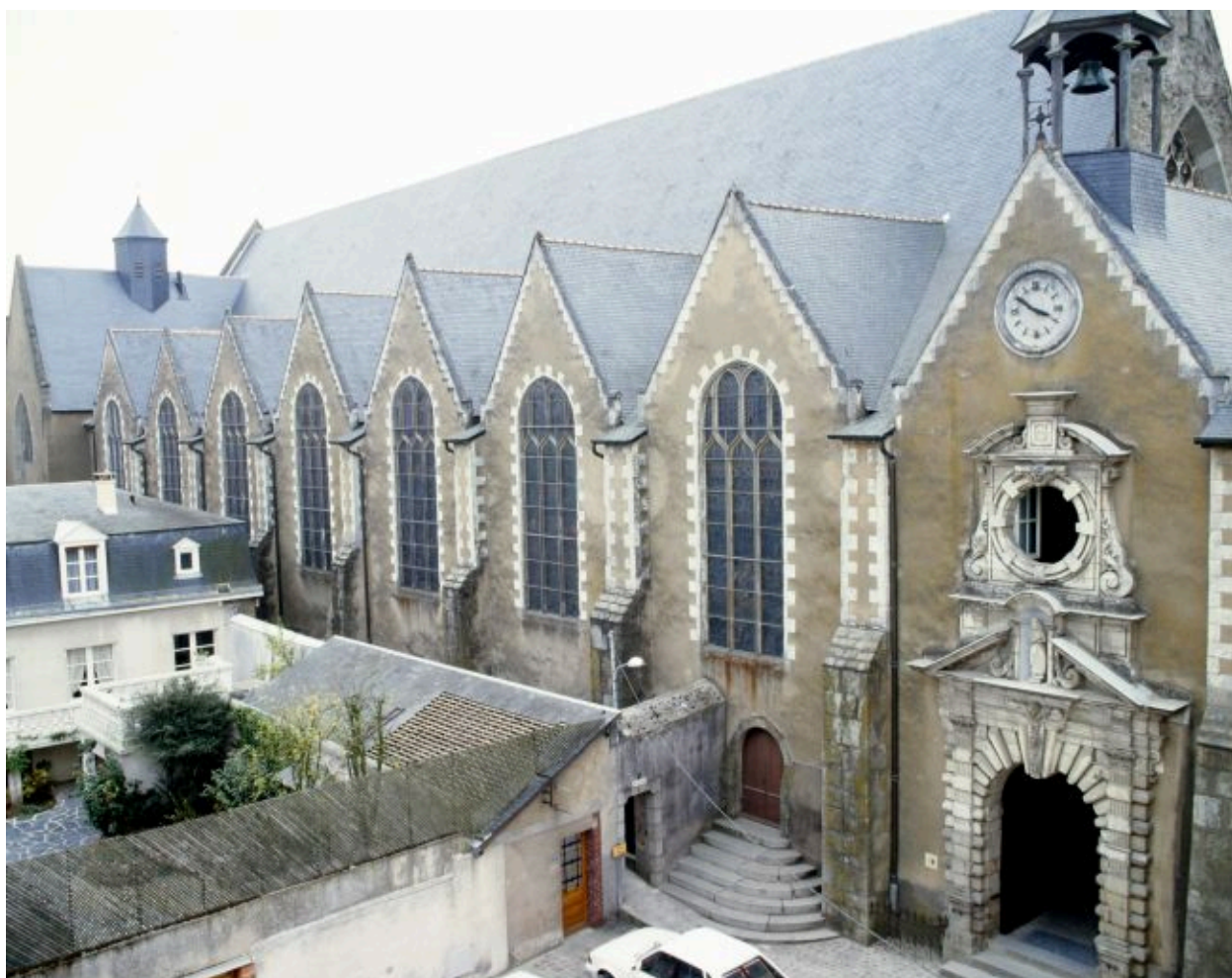
Eglise, élévation nord : vue d'ensemble.
