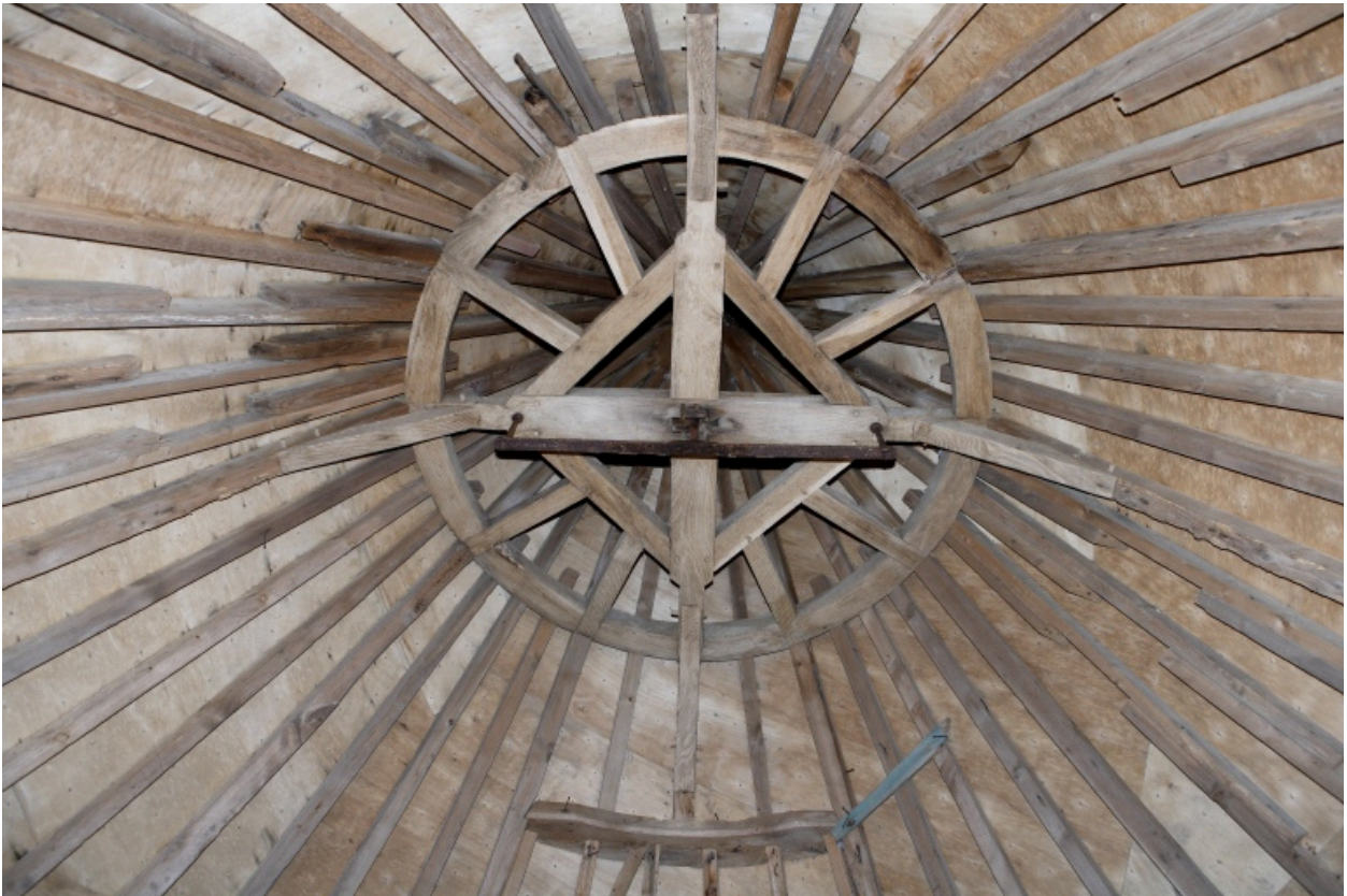
Étage de comble ; charpente de la coiffe.
