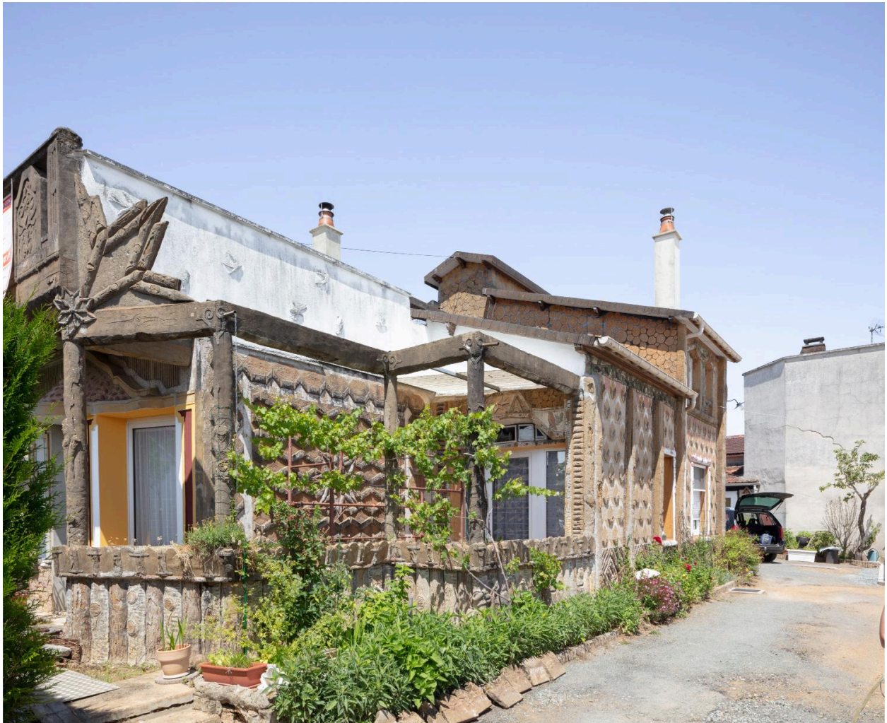
Vue de la façade sud de la maison depuis l'ouest.
