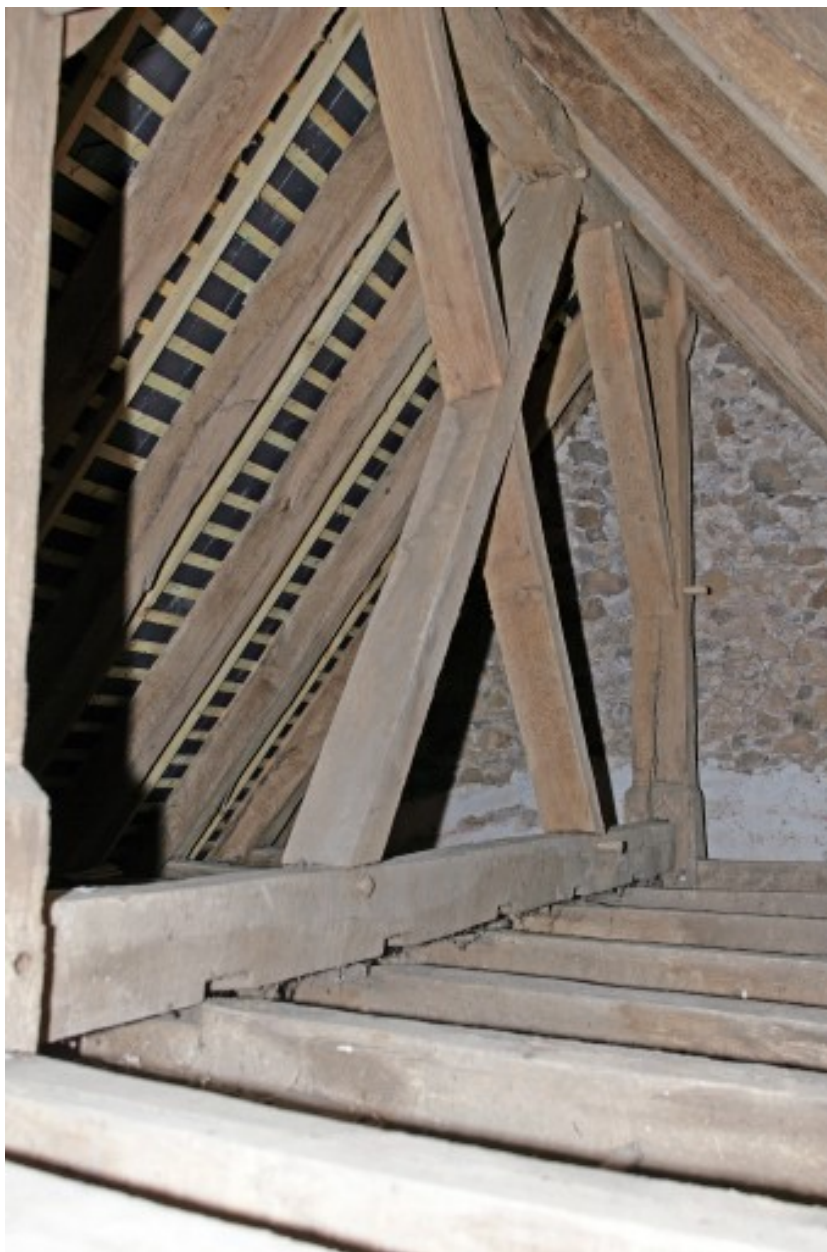
La charpente : vue de détail des chevrons, des faux-entraits et des aisseliers.
