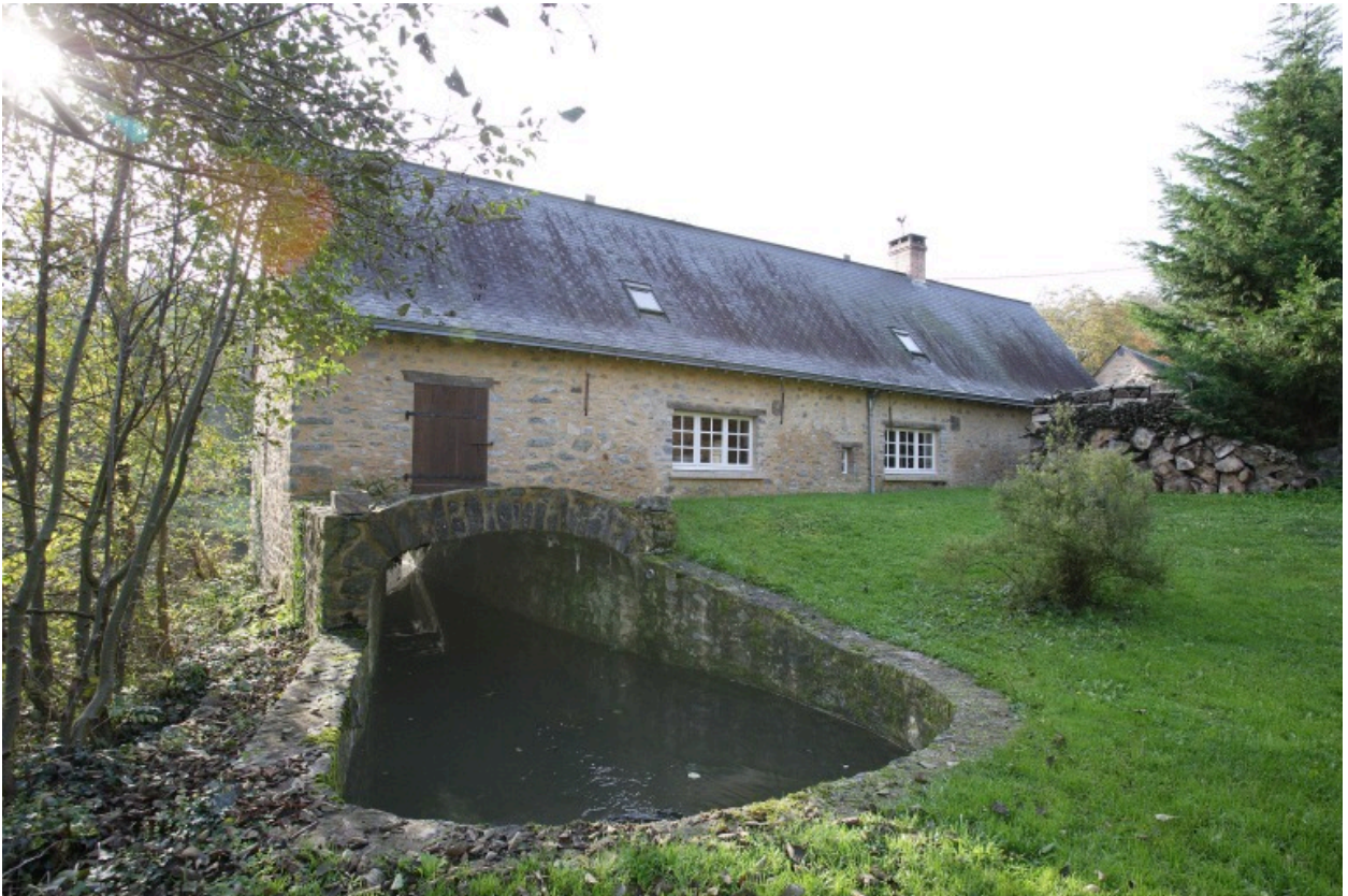
L'ancien moulin-logis vu depuis l'amont au nord.
