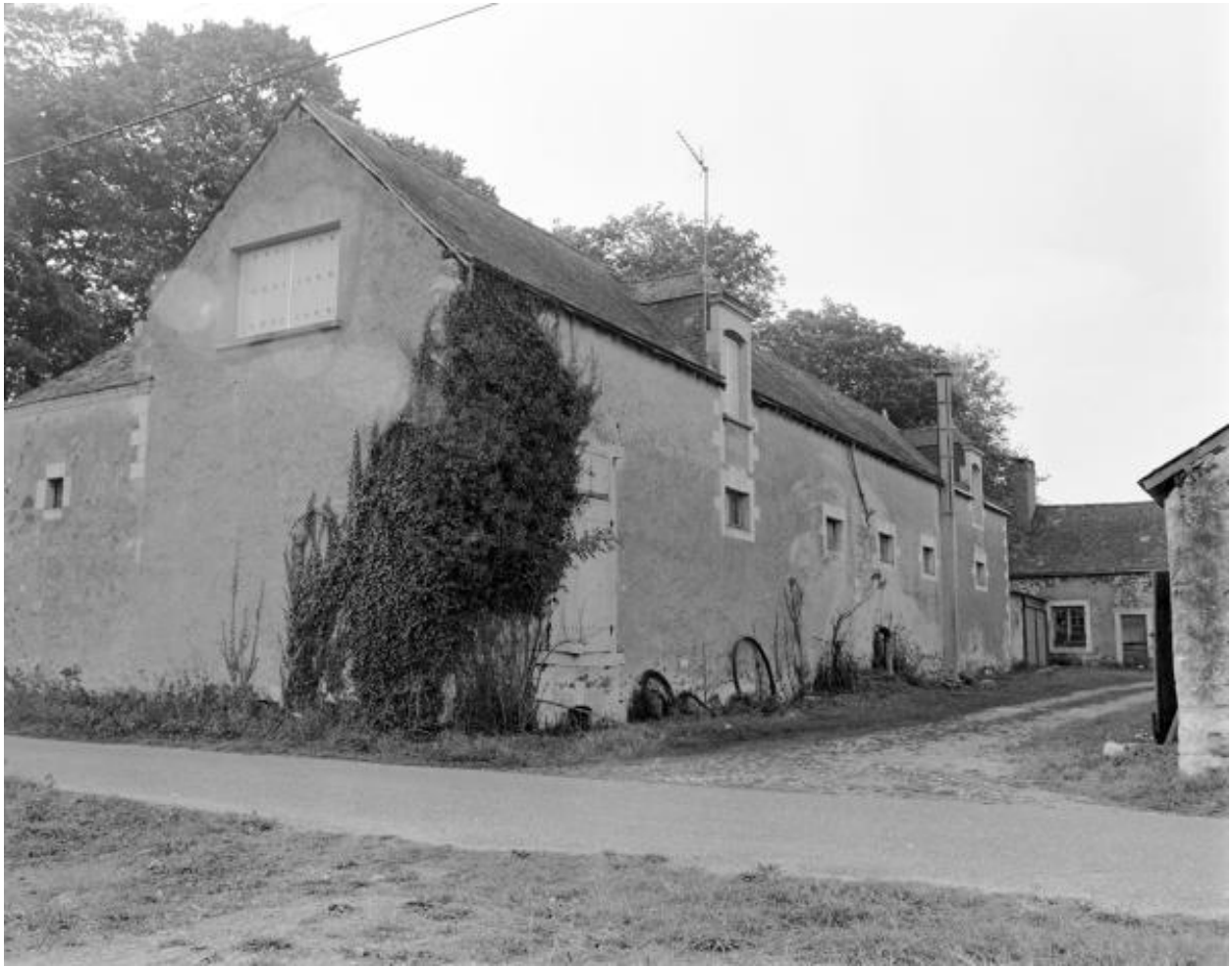
Ecuries, élévation postérieure, 1985.
