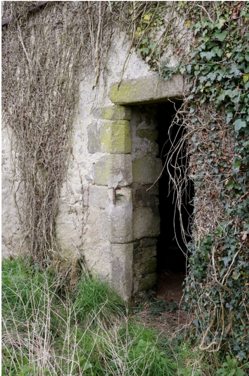
Détail de la porte nord du 1er logis.
