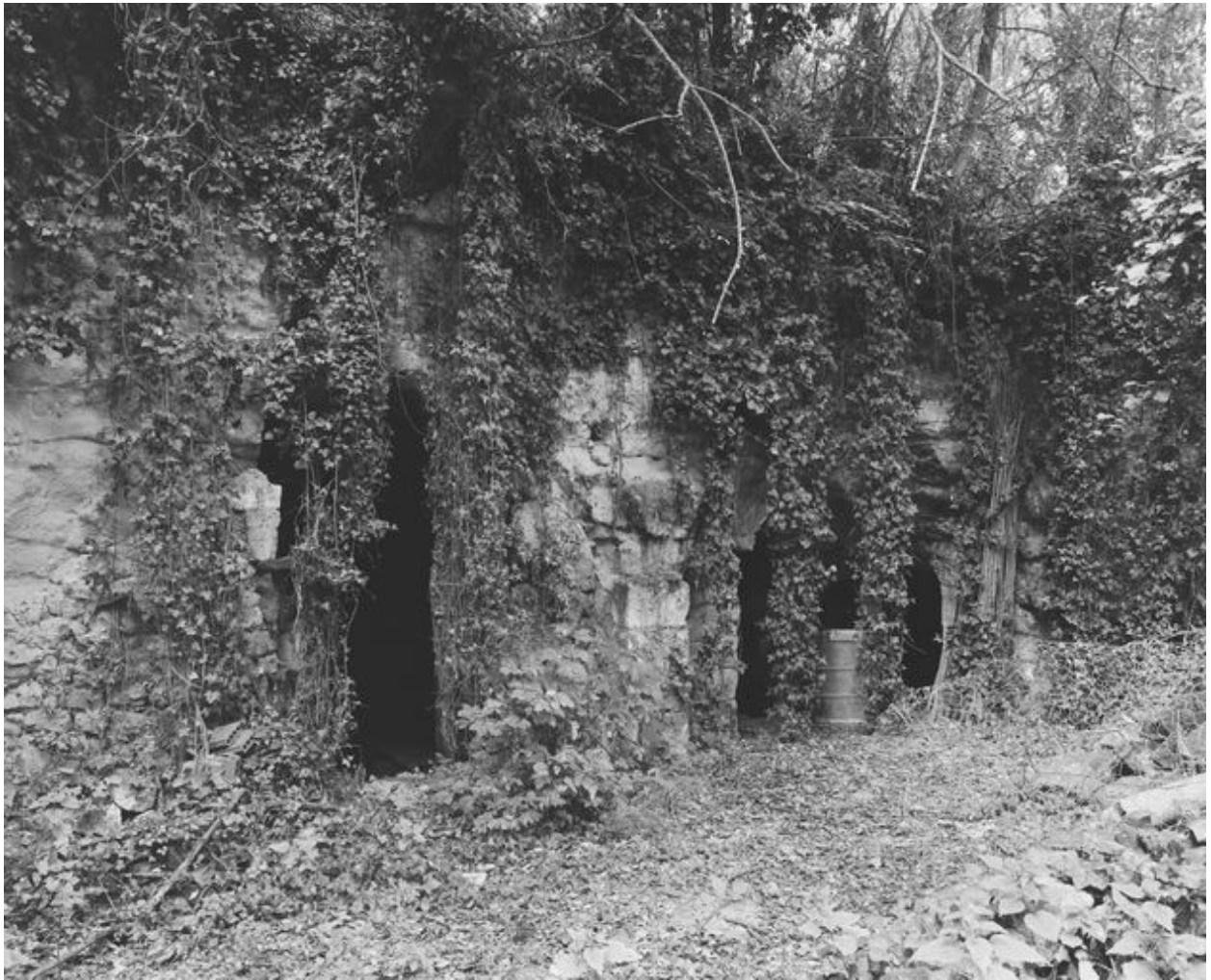
Entrées de caves, au nord (en 1996).
