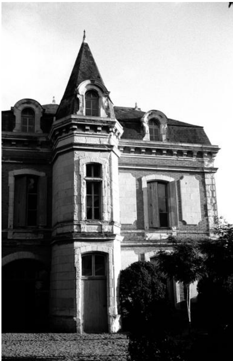
Vue de la façade nord du logis n° 2.
