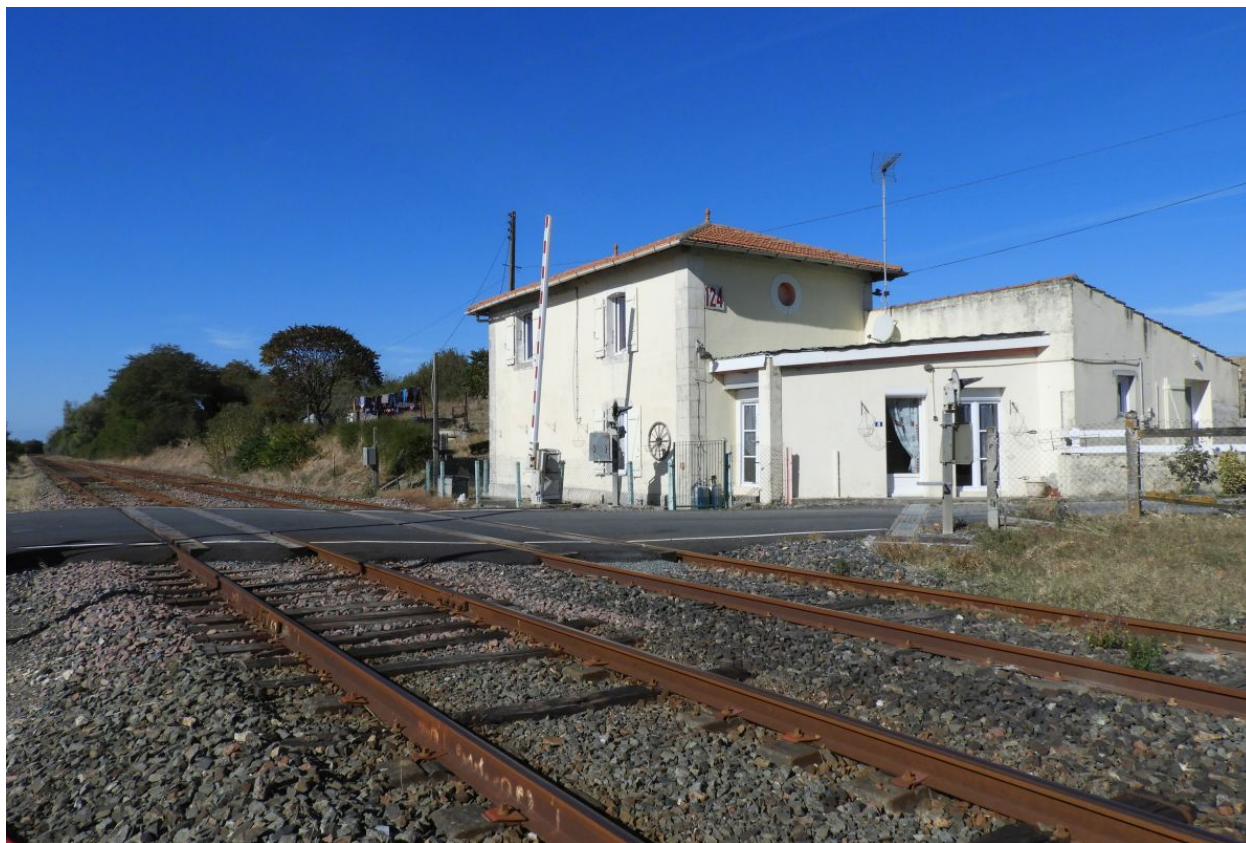
La maison de garde-barrière vue depuis l'est.
