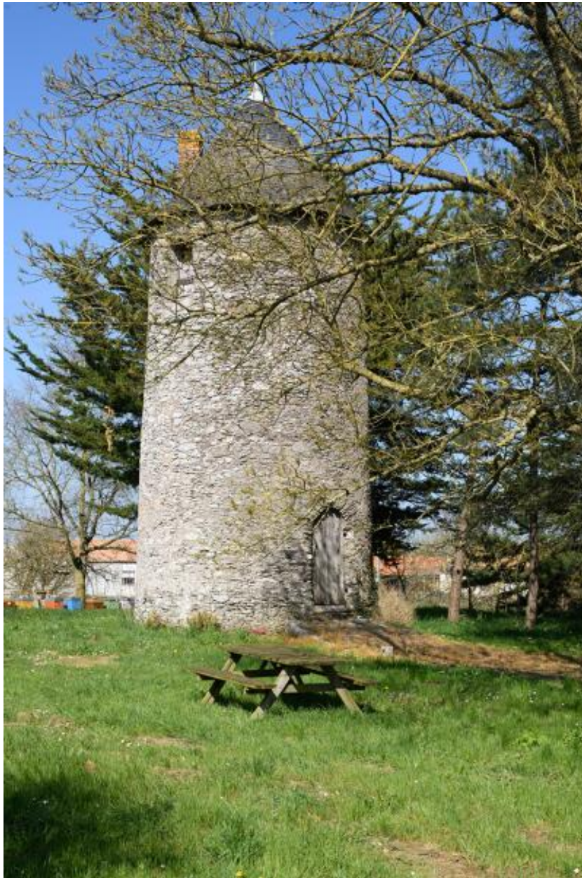
Moulin à farine dit moulin des Buttes (n° 1) ou moulin de l'Ouche-Neuve. Vue d'ensemble depuis le sud-ouest.
