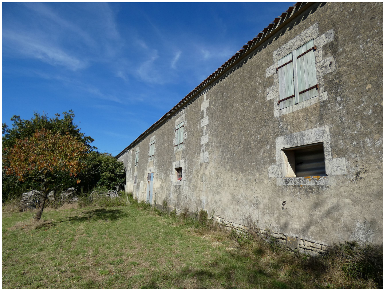
La façade sud de la grange-étable.
