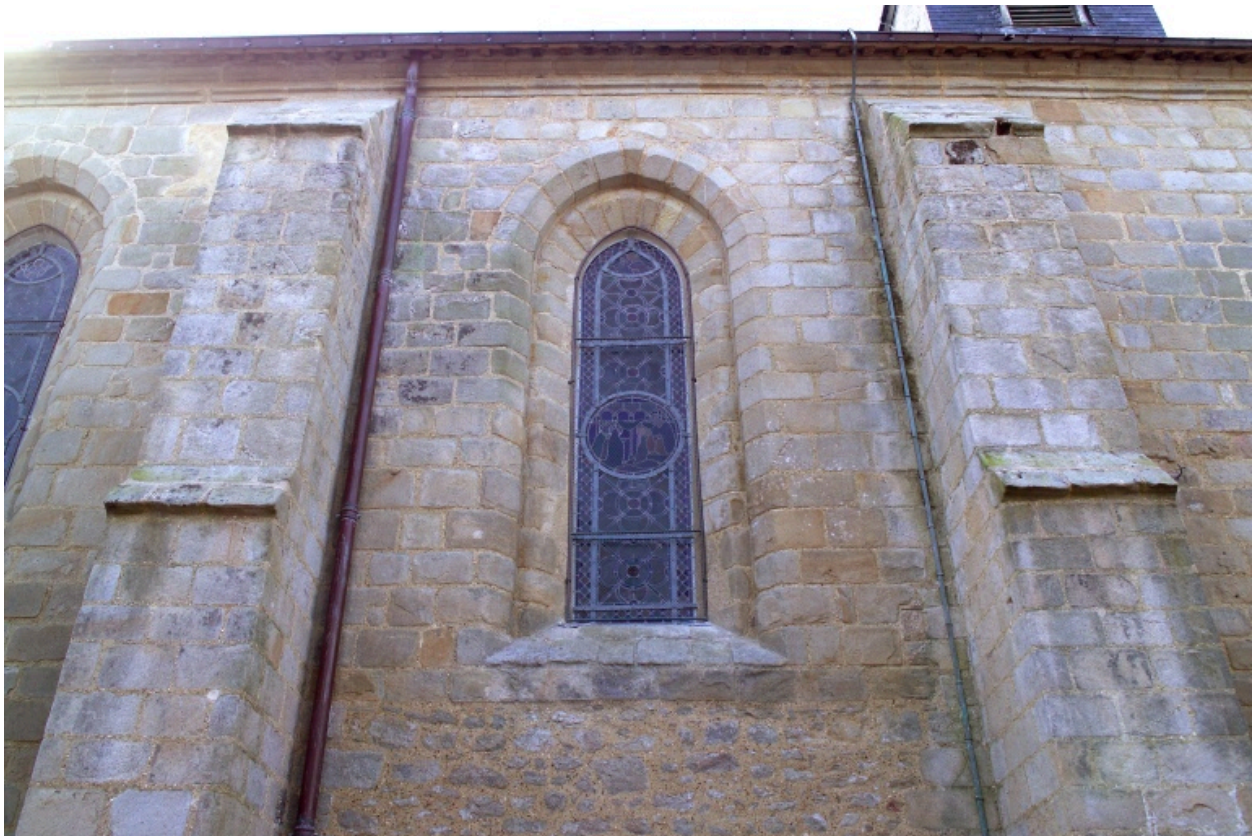
Mur nord, détail de la baie de la seconde travée.
