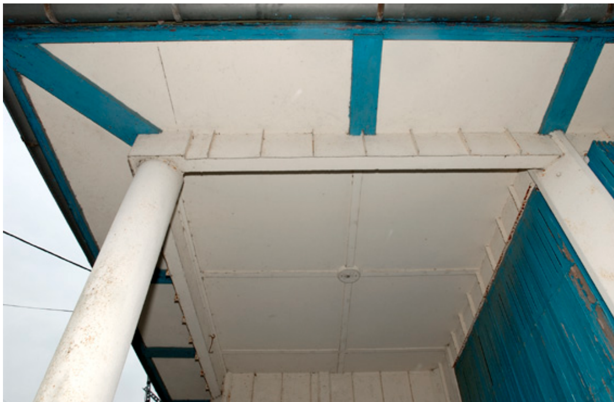
Détail de la toiture d'une maison de type Fillod (Maison du Mineur et des Energies).
