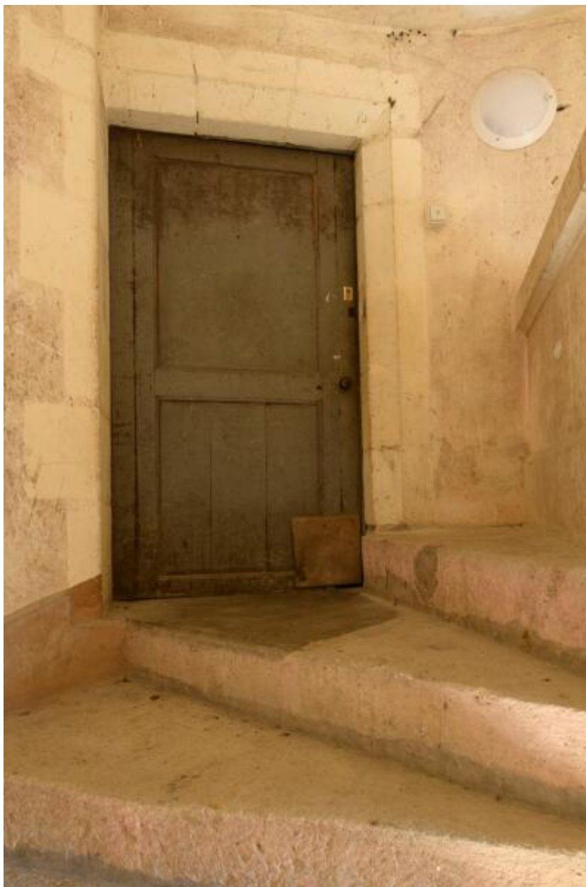
Vue de la porte du comble ouvrant sur l'escalier.
