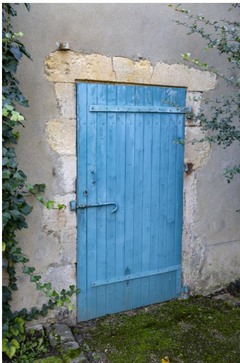
Vue de la porte sud de la grange.
