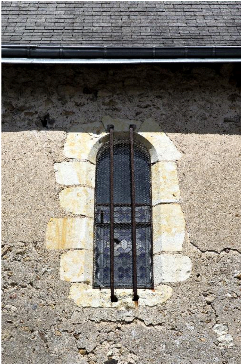
Nef, façade sud : baie au-dessus de l'entrée.
