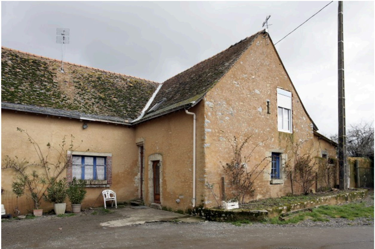
Le logis vu depuis le sud-ouest.
