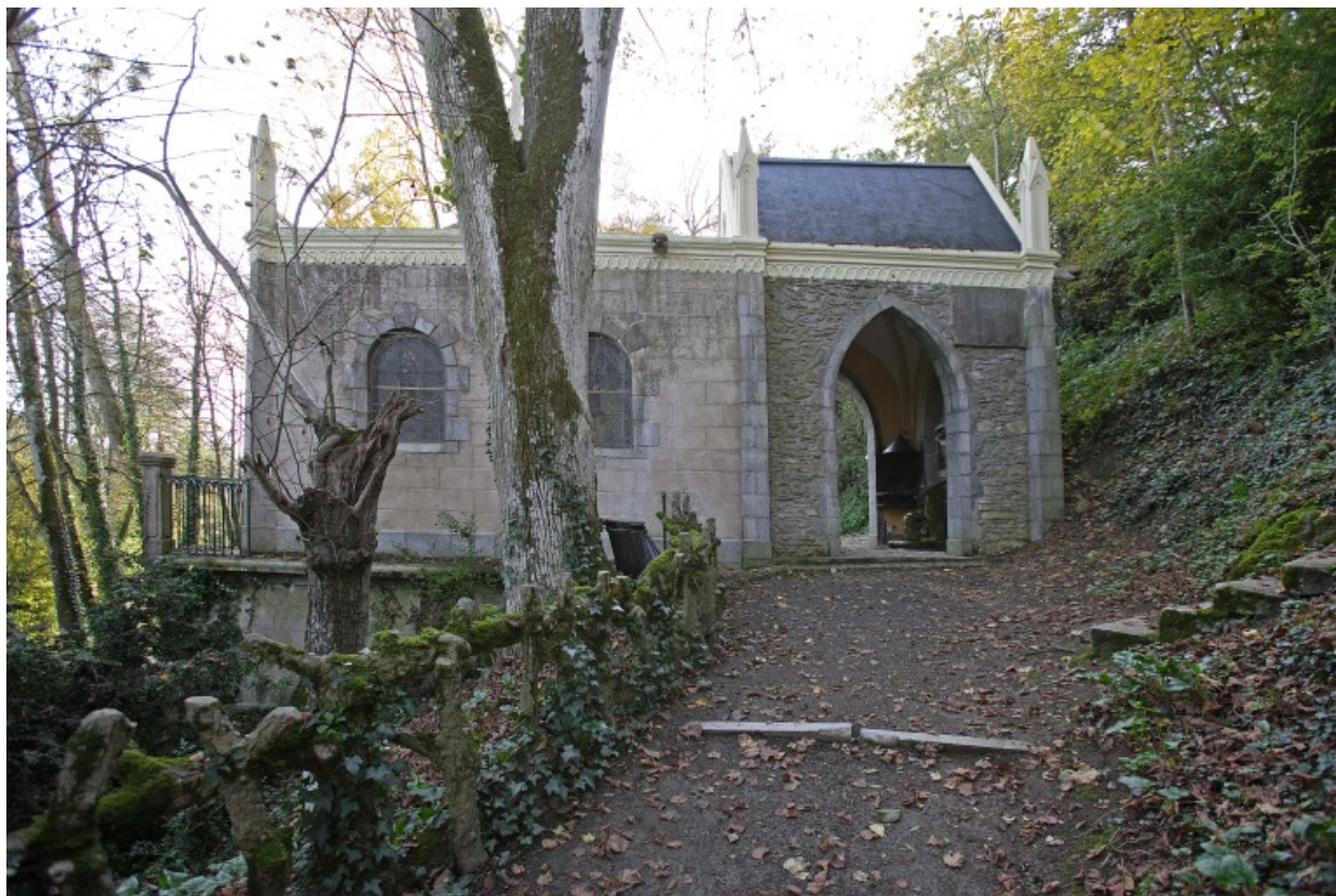
Vue depuis le nord.
