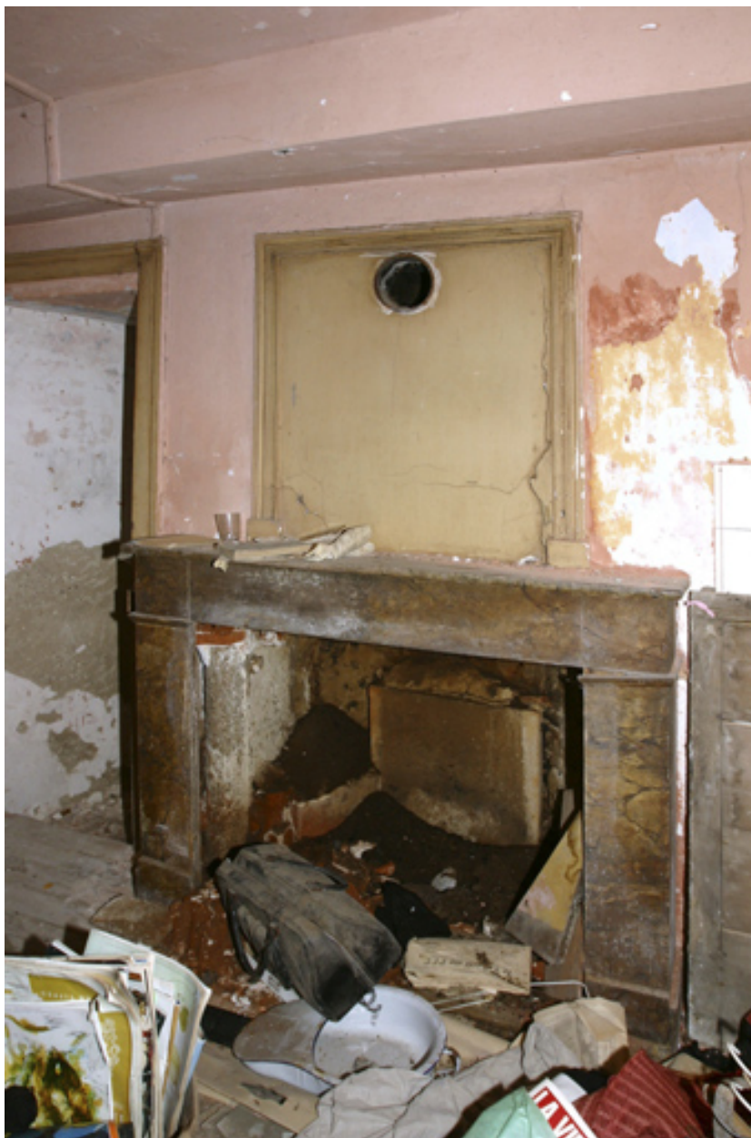
Cheminée à l'étage de l'aile nord, salle est.
