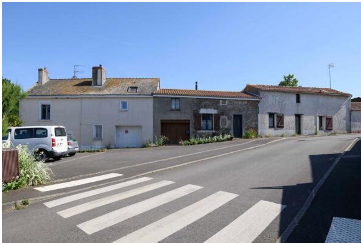
Bourg. 1 à 3 rue des Moulins. Rangée d'habitations (17e siècle-20e siècle).
