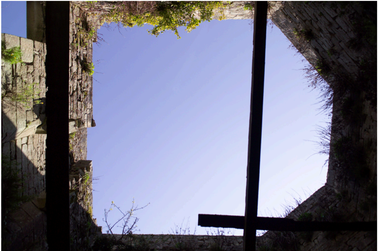
Parement interne vu depuis le rez-de-chaussée.
