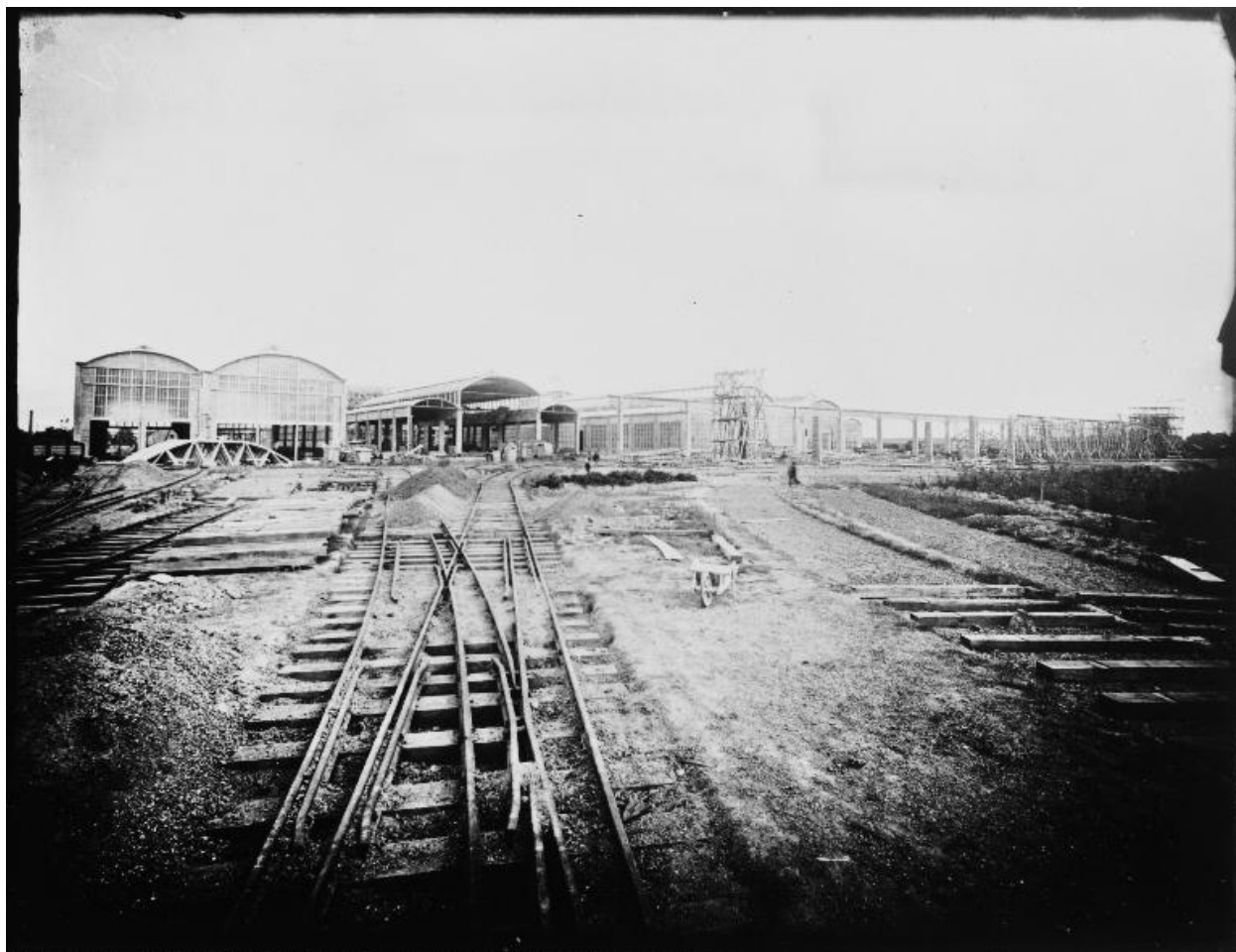
L'usine en construction, vue vers sud, 1919.
