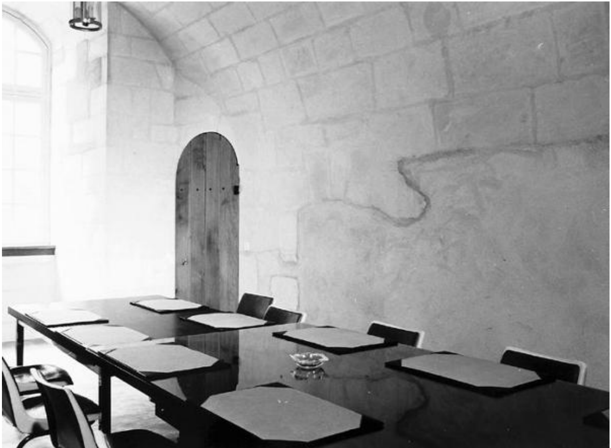
Pavillon sud-est de l'abbaye, chartrier entresolé : mur ouest. Au fond, l'unique accès à cette pièce : porte d'un escalier dérobé menant à l'oratoire du prieur.
