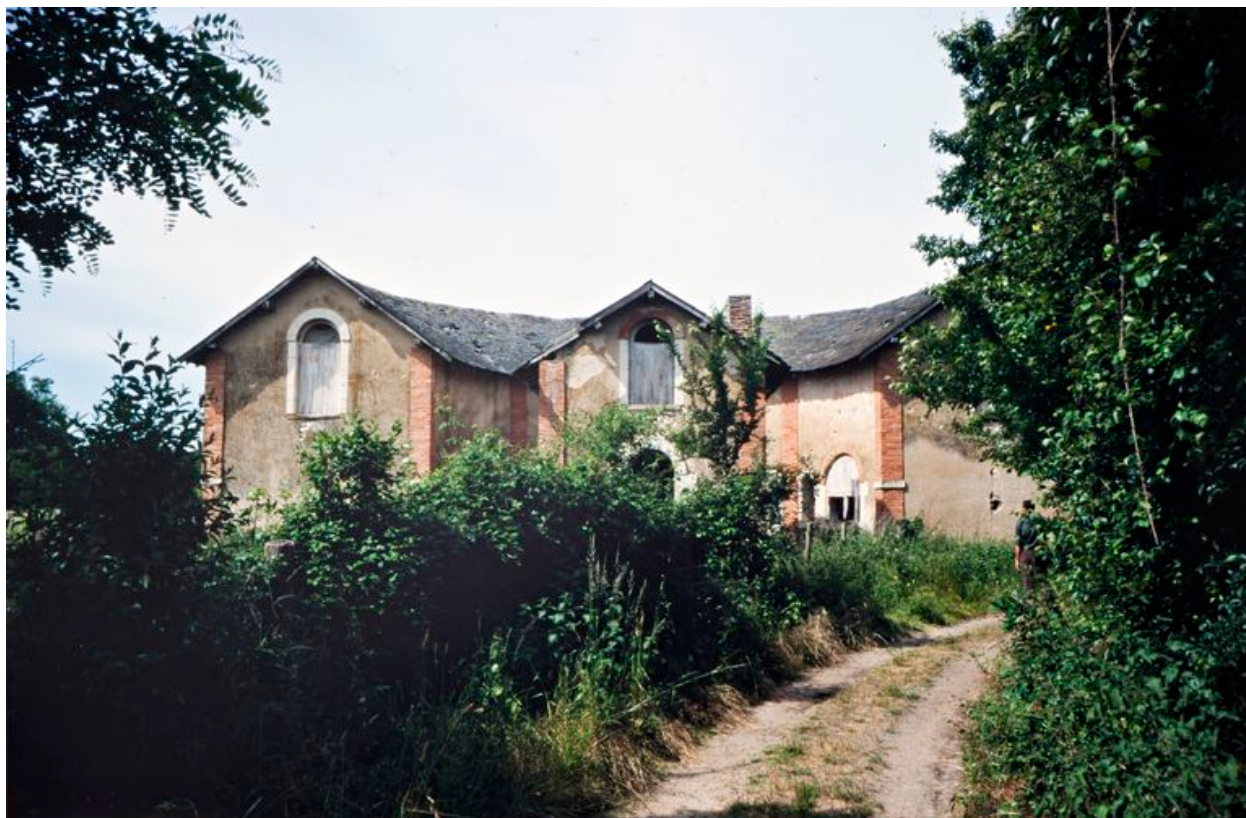
Façade postérieure : les écuries en fer à cheval et le logement au centre.
