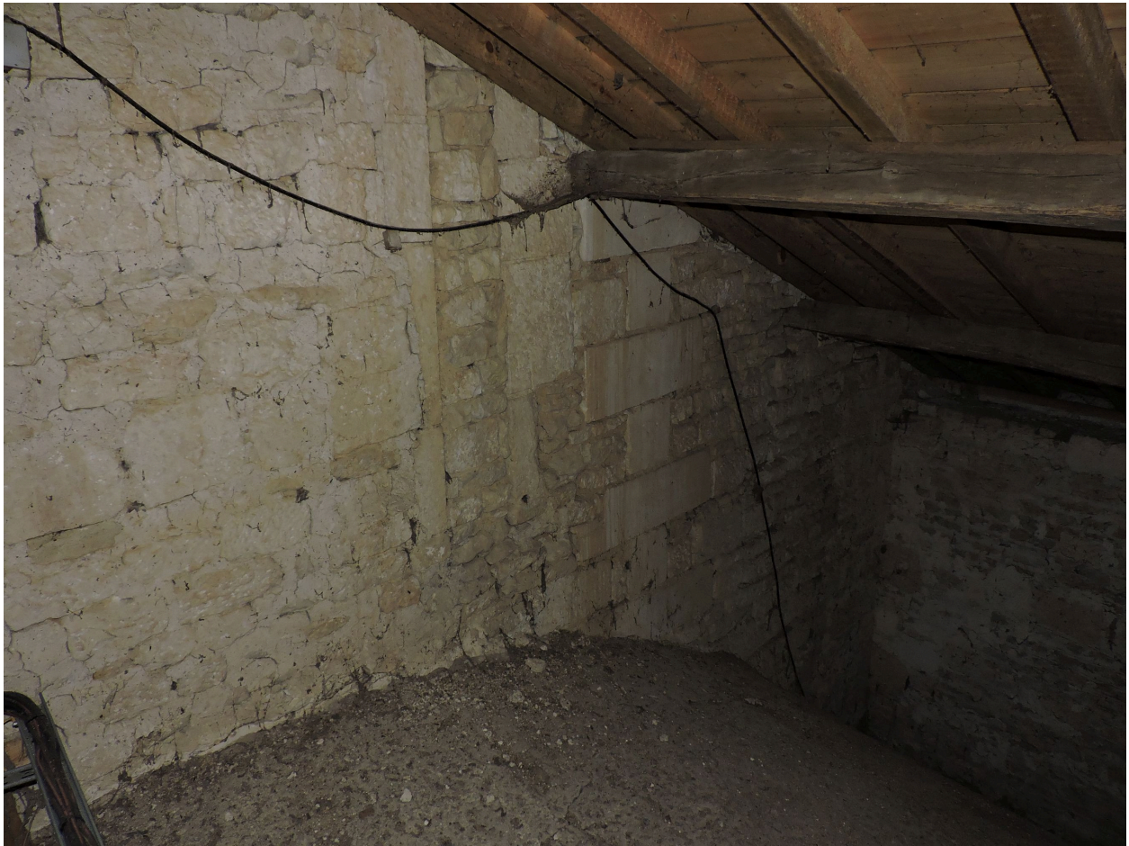
Mur de refend entre la voûte de la nef et celle de la première travée du chœur, ancienne élévation ouest de l'ancien clocher, vu depuis l'ouest.
