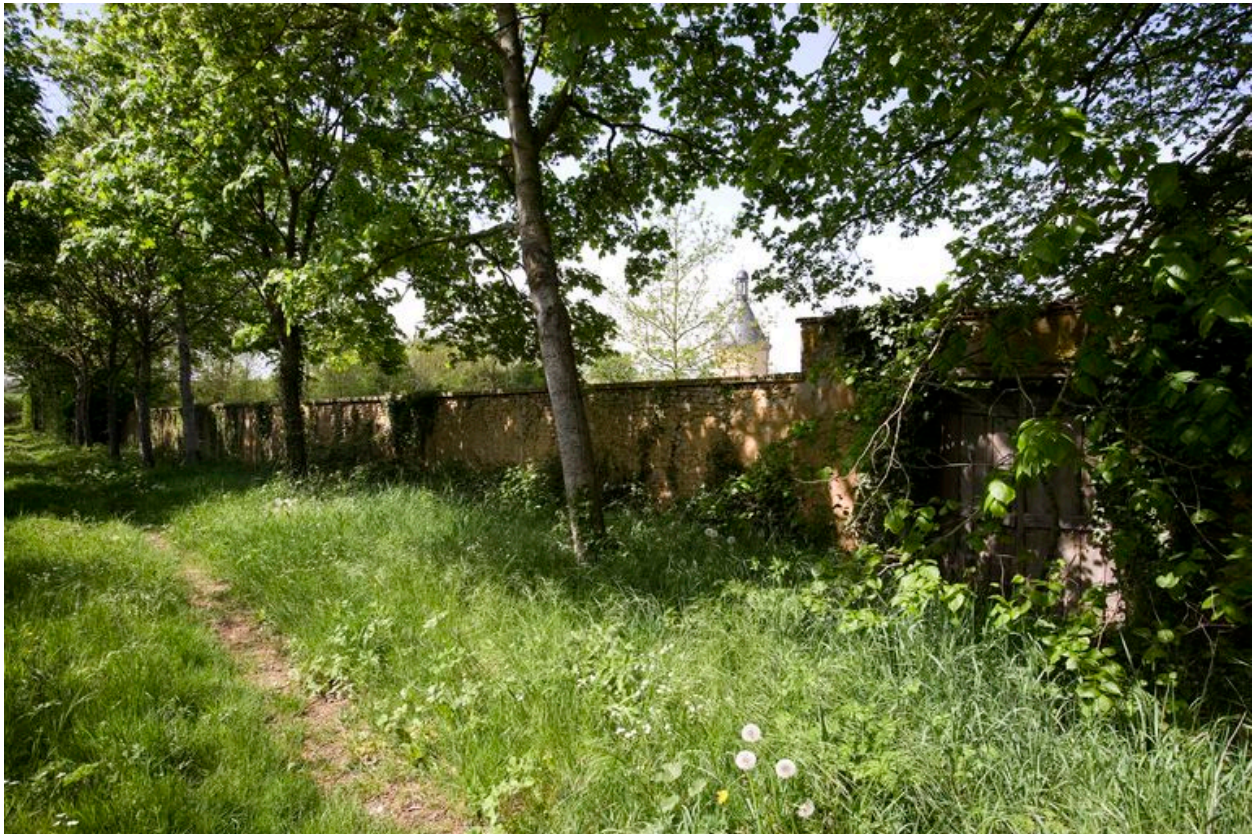
Mur de clôture du potager.
