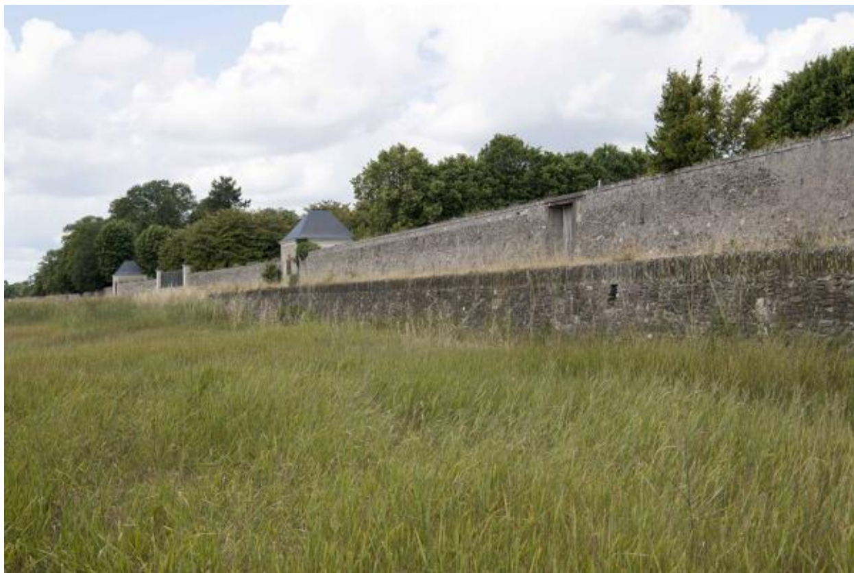
Vue du mur de clôture et du chemin de halage.
