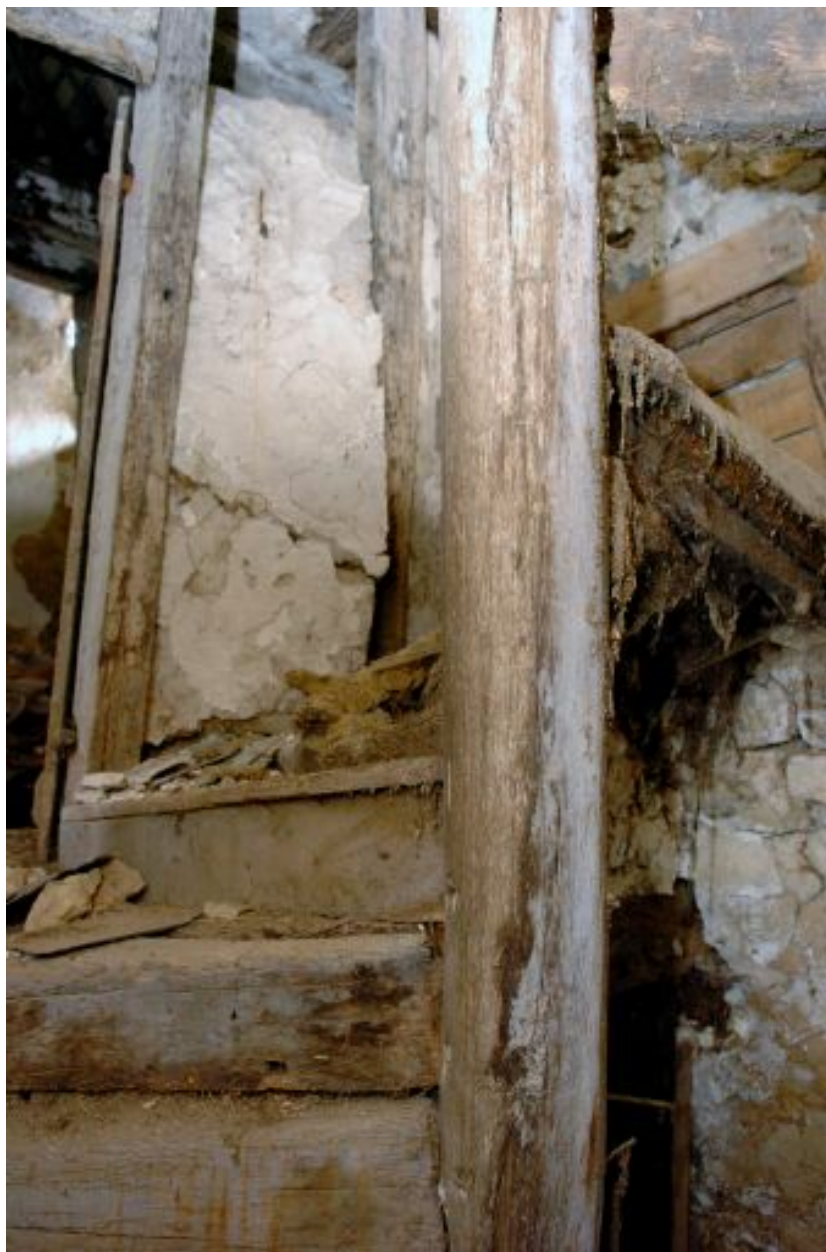
Escalier dans œuvre en vis en bois.
