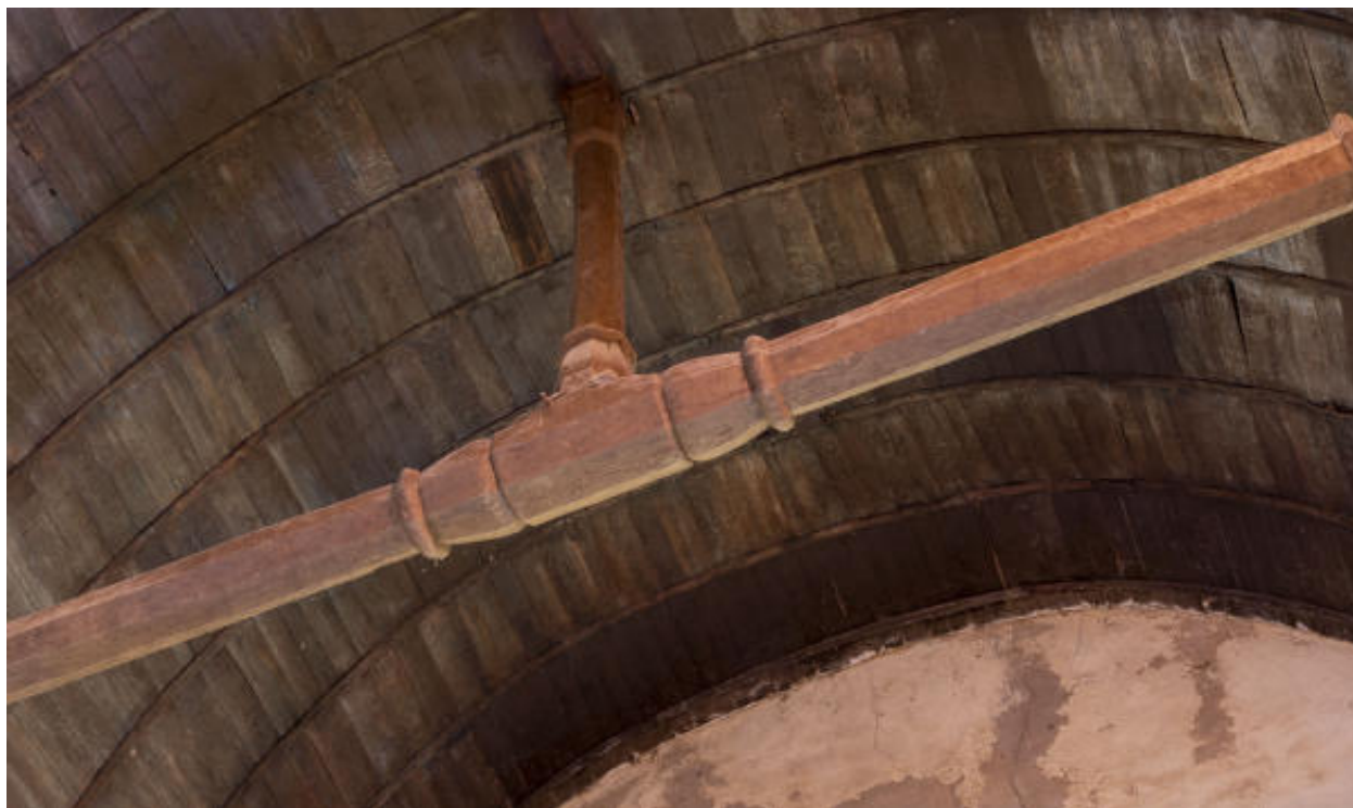
La charpente et le lambris de la chapelle sud.
