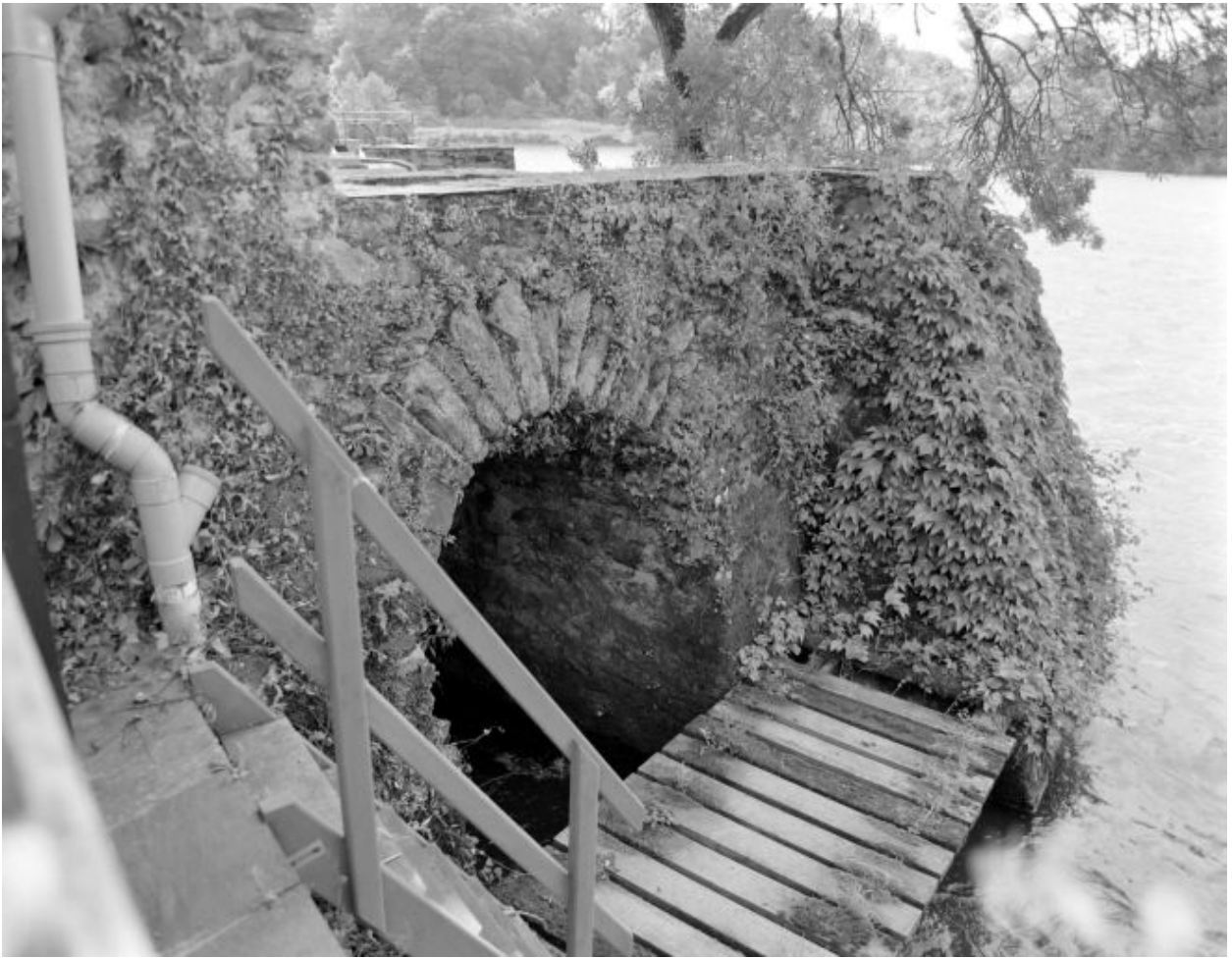
La sortie du coursier, vue d'aval.
