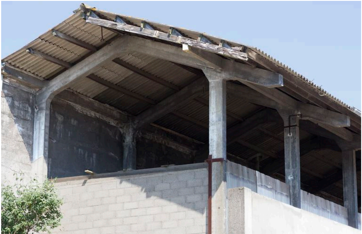
B : service de maintenance, détail des poutres en béton.
