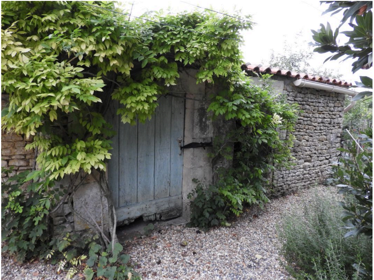
Le fournil-buanderie à l'extrémité de l'aile de dépendances au nord-est de la maison.
