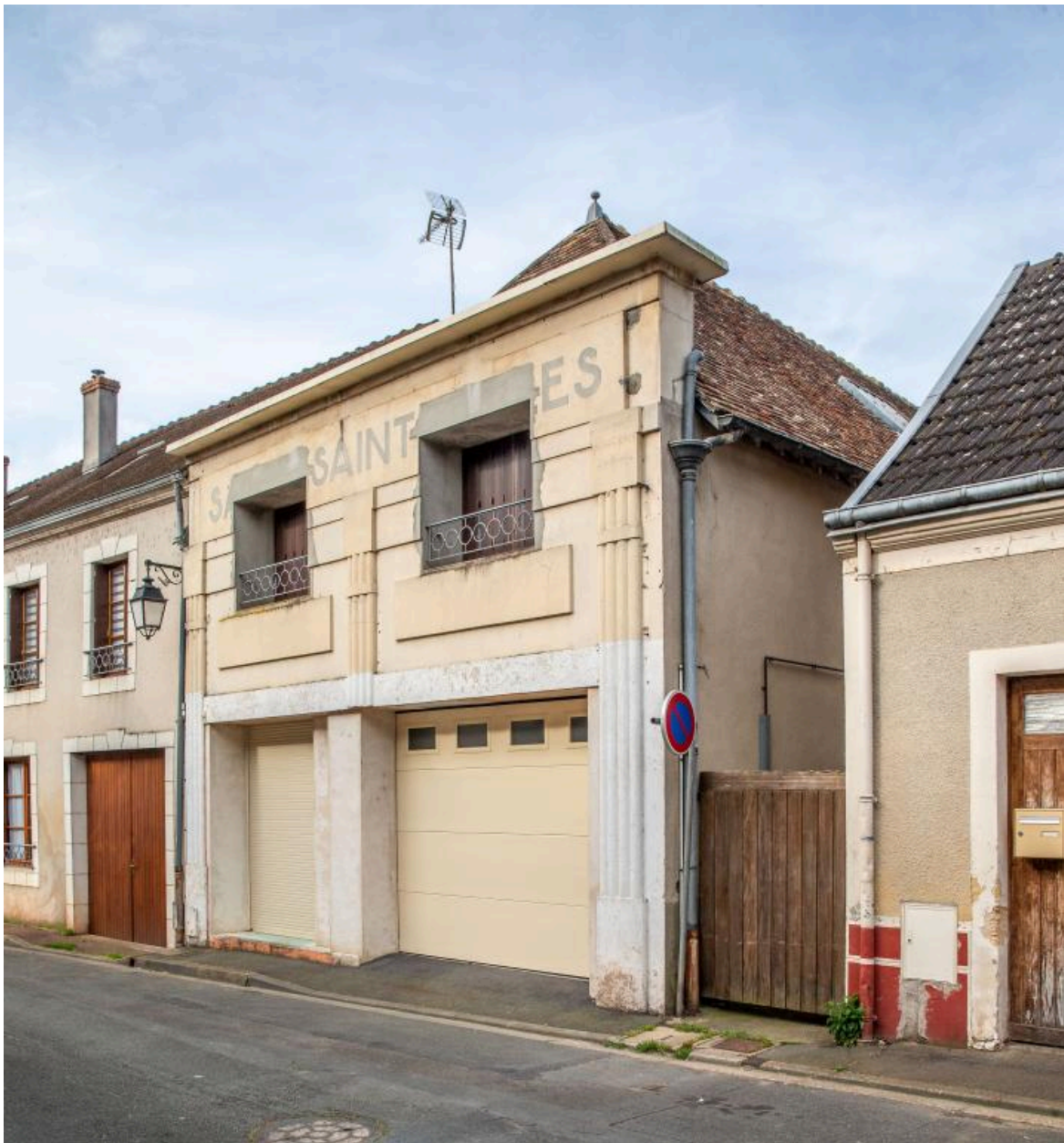
L'ancienne salle paroissiale.
