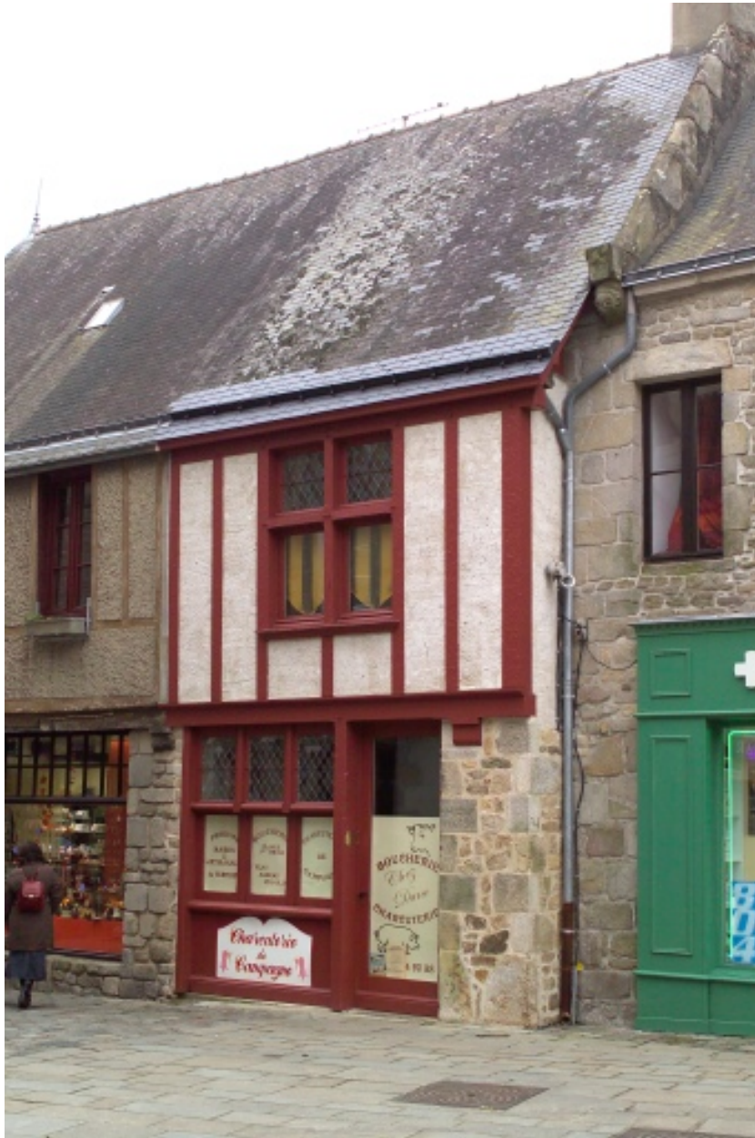
Détail de la moitié occidentale de la façade nord après restauration.
