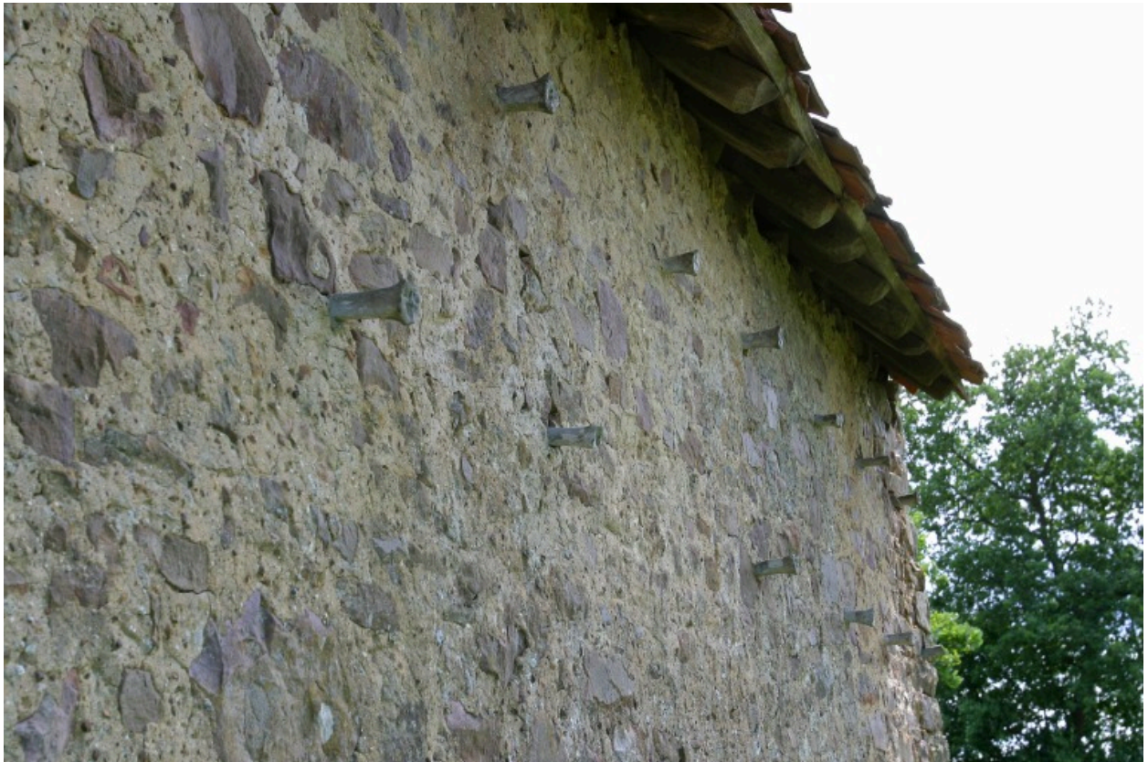
Détail du mur sud de l'étable : attaches en os.
