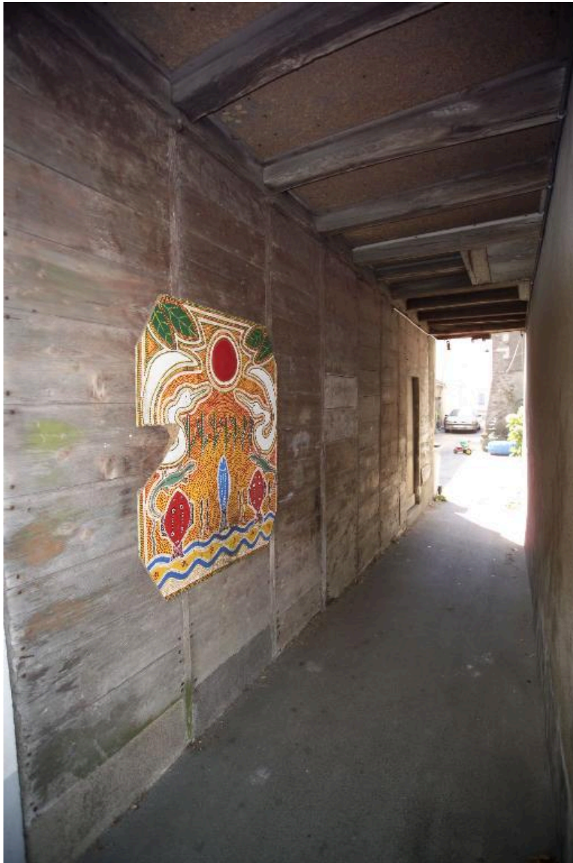
Vue du passage depuis la rue du Faisan.
