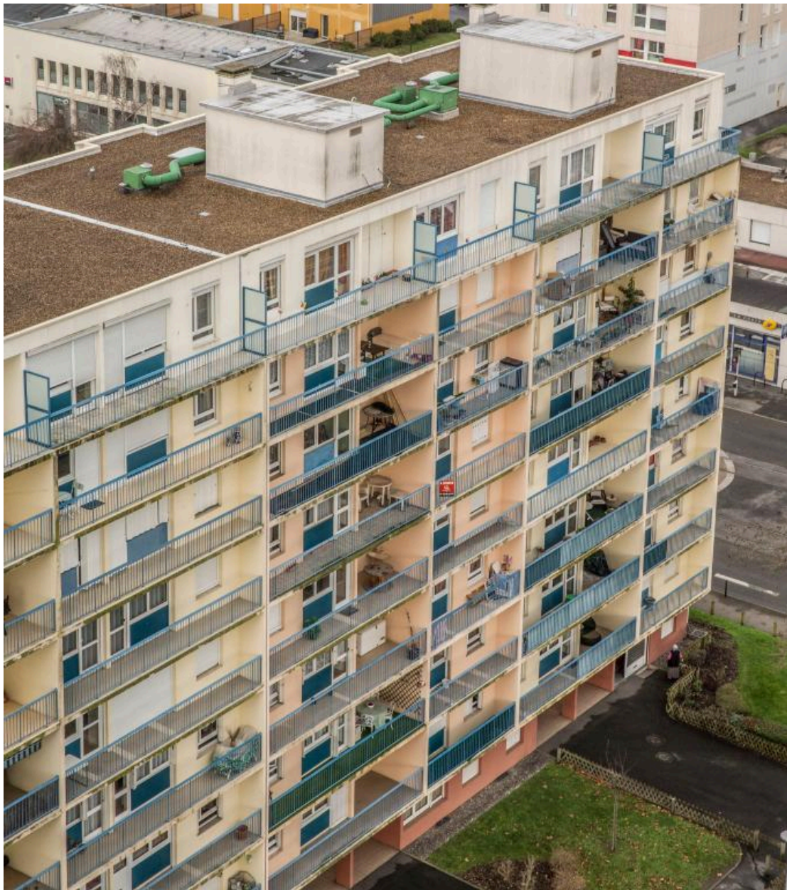
Loggias d'une barre de logements depuis une tour voisine.
