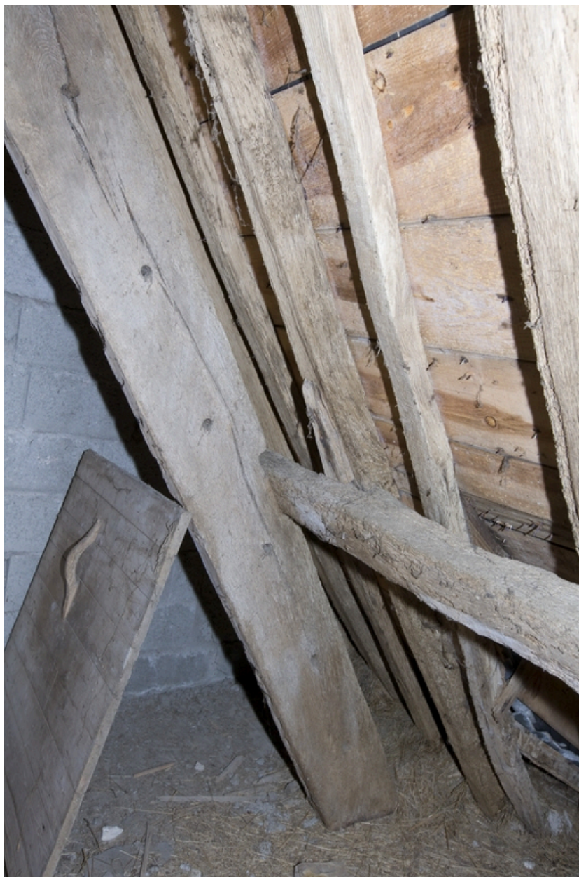
N° 10 rue Basse. Comble. Trappe d'accès au comble.
