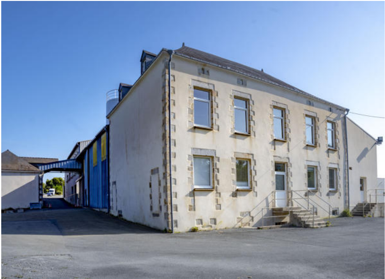
La façade postérieure de la maison.
