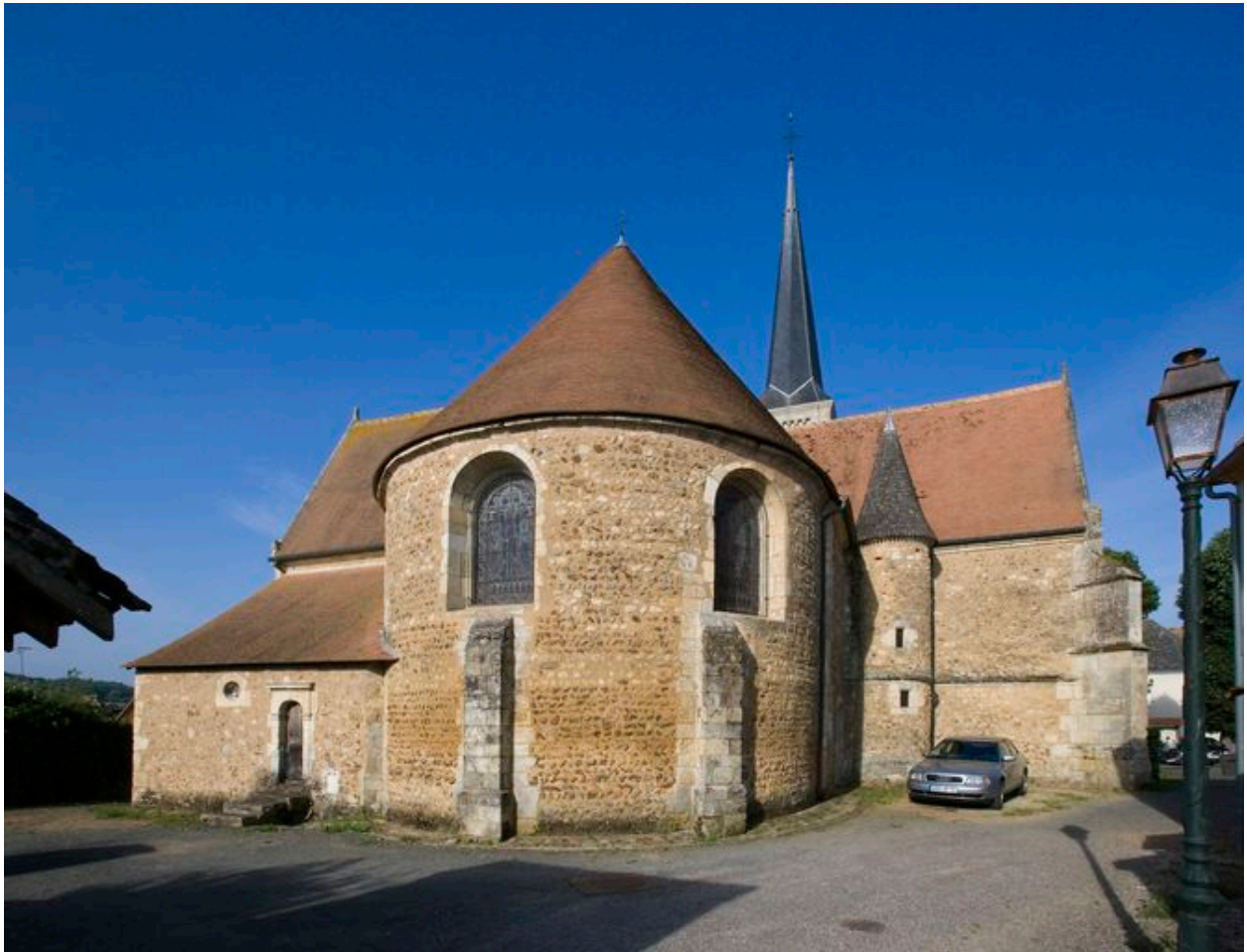
Vue générale depuis l'est
