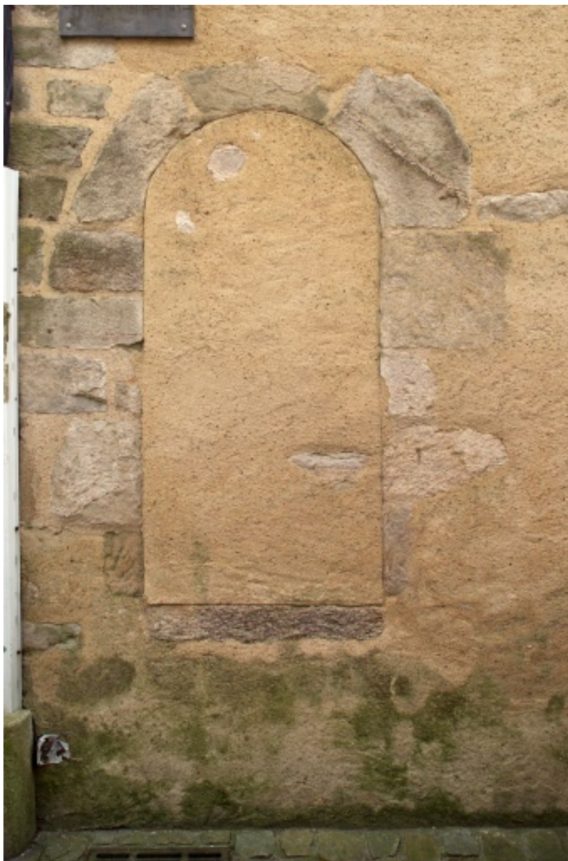
Pignon nord, détail de la porte murée.
