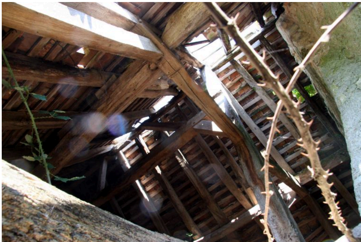
La salle principale : charpente avec sous faîtage.
