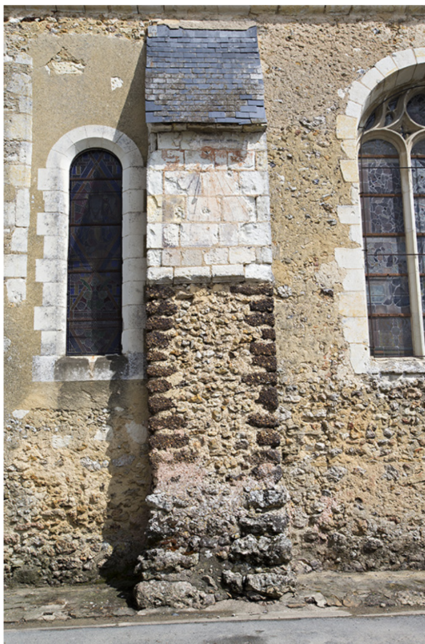
Mur sud de la nef : épais contrefort en grison et pierre de taille calcaire.
