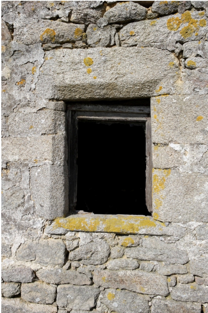
Détail de l'une des baies de la façade est.
